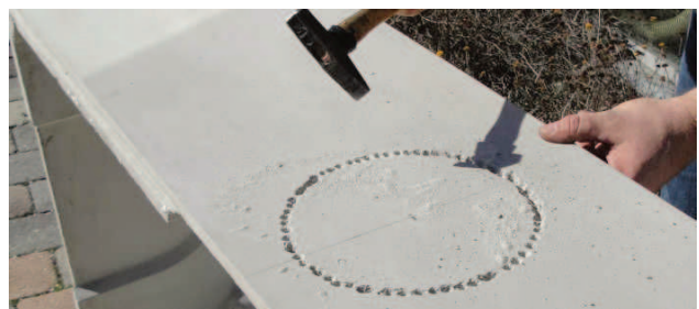
Abb. 20: Ausbruch herstellen mit dem Bohrer
